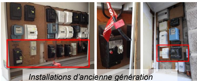
Différents disjoncteurs de branchement
